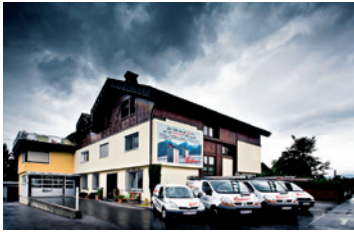
ENTNER-DACH in Rankweil
